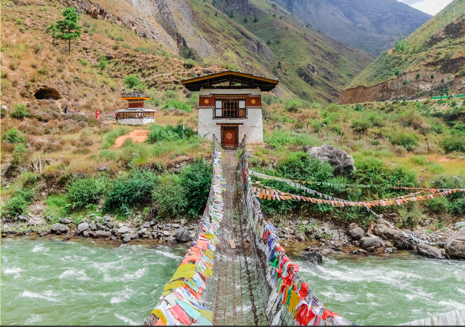
Paro - Puente de hierro en el monasterio de Tamchog Lhakhang
